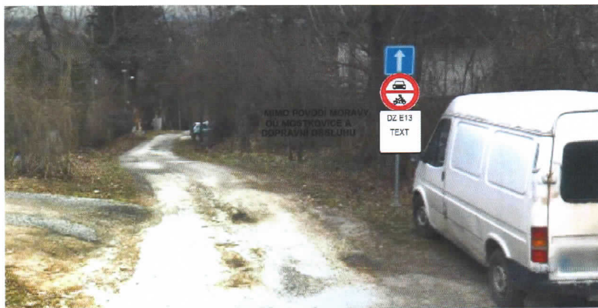
Foto č. 8 – Doplnění DZ B11 (Zákaz vjezdu všech motorových vozidel) + E13 (text)-mimo POVODÍ MORAVY, OBECNÍ ÚŘAD MOSTKOVICE, DOPRAVNÍ OBSLUHU, PČR A HOTEL ZLECHOV
