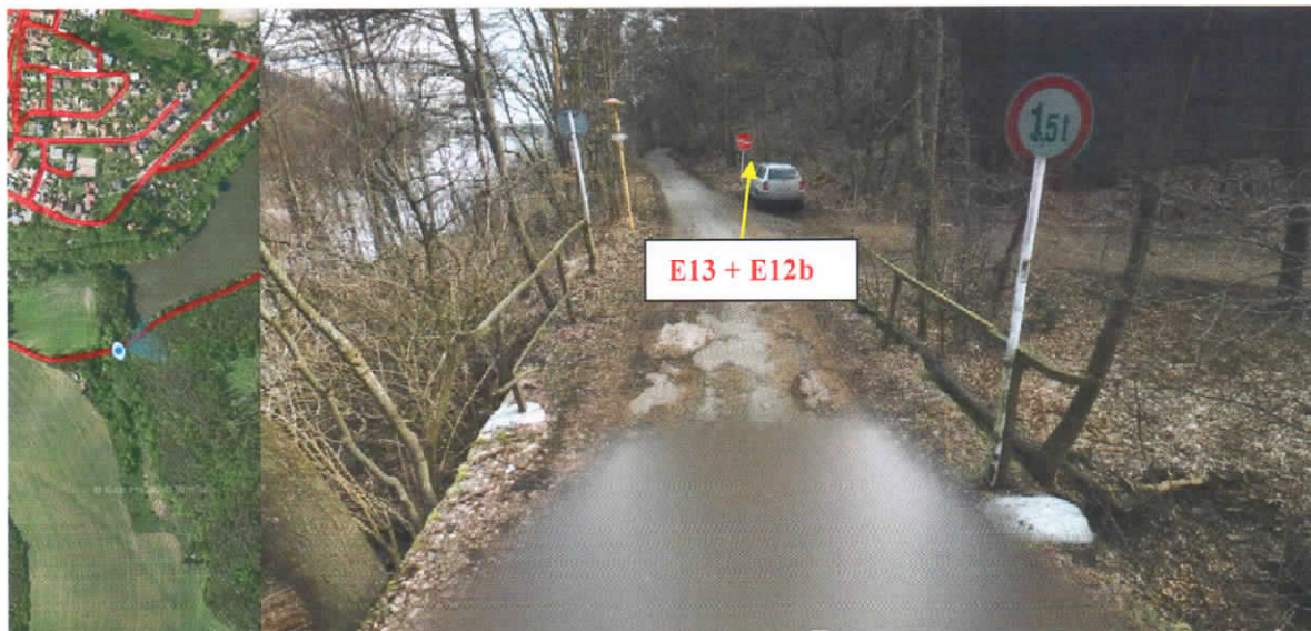
Foto č. 4 - Doplnit DZ E13 (cyklistům vjezd povolen) + E12b (vjezd cyklistů v protisměru povolen)
