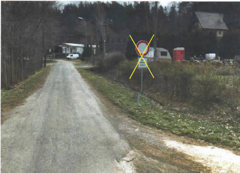
Foto č. 1 - Dopravní značení musí tvořit ucelený celek, kdy zde dochází k situaci, kdy vozidla, která k dopravní značce dojedou, již nemohou legálně pokračovat v jízdě. Zde lze dopravní značku B 1 "Zákaz vjezdu" + E 13 "Text" odstranit.
