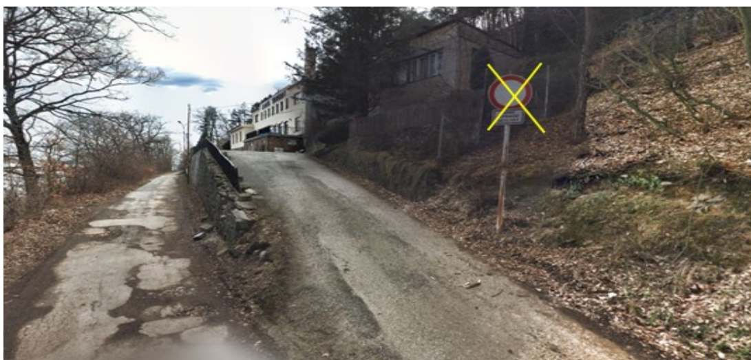
Foto č. 5 – Dopravní značka bude odstraněna
