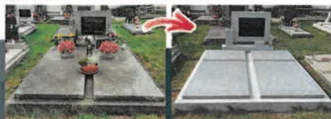
Ukázka realizace: broušení teracových rámu a výměna desek za žulové.
